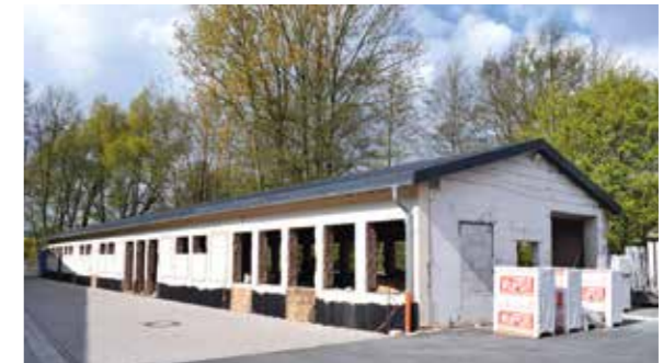
Die Kita Lage nimmt immer mehr Formen an
